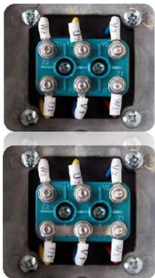
MOTEURS AVEC 6 BORNIERIS DOUBLE POLARITÉ CONNEXION YY/ \Delta
